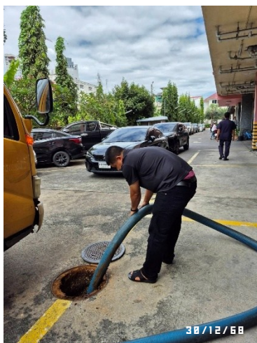
รูปที่ 1 เครื่องเติมอากาศลงบ่อเกรอะ
