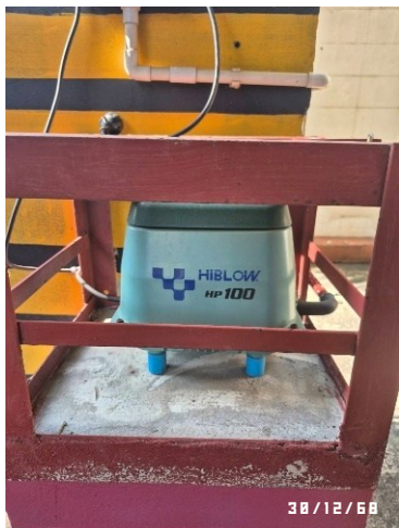
รูปที่ 1 เครื่องเติมอากาศลงบ่อเกรอะ
