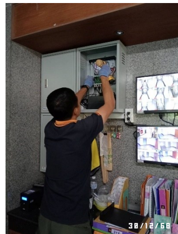
รูปที่ 28 เจ้าหน้าที่ตรวจเช็คระบบกล้องวงจรปิด
