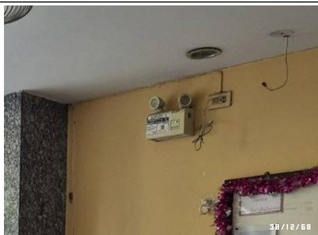
รูปที่ 18 ไฟฟ้าส่องสว่างฉุกเฉิน
