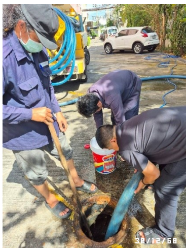
รูปที่ 3 สำนักงานเขตบางกอกน้อย เข้ามาสูบล้างปฏิภาณของเสียไปกำจัดอย่างถูกสุขลักษณะ
