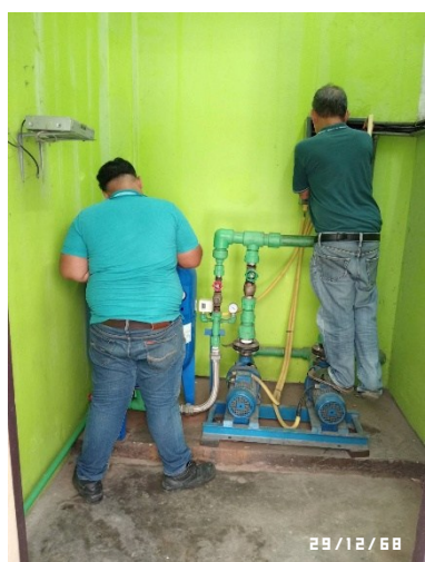
รูปที่ 35 เจ้าหน้าที่ตรวจสอบดูแลระบบปั้มน้ำของอาคาร
