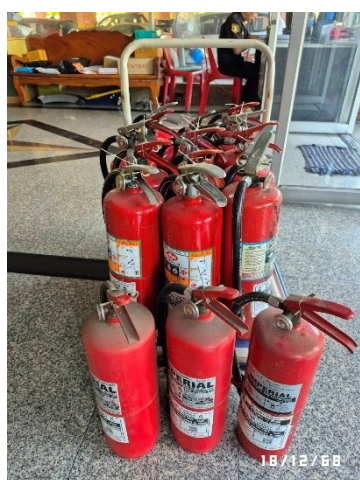
รูปที่ 16 เจ้าหน้าที่ตรวจเช็คถังดับเพลิง และเปลี่ยนถังดับเพลิง
