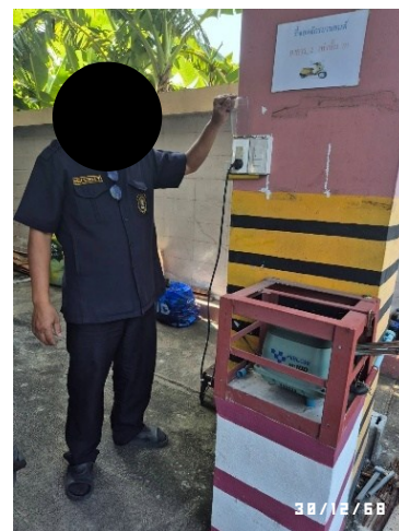
รูปที่ 2 เจ้าหน้าที่ตรวจสอบเครื่องเติมอากาศลงบ่อเกรอะ
