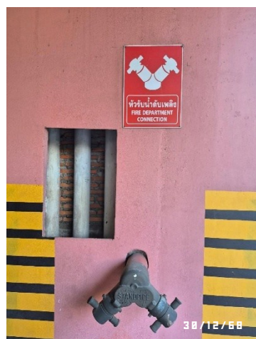
รูปที่ 17 ท่อเย็นและหัวรับน้ำดับเพลิง
